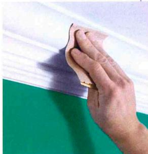
7. Для шлифовки поверхности используйте наждачную бумагу.
