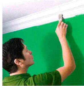
6. С помощью ножика для замазки швов обработайте стыки карнизов.
